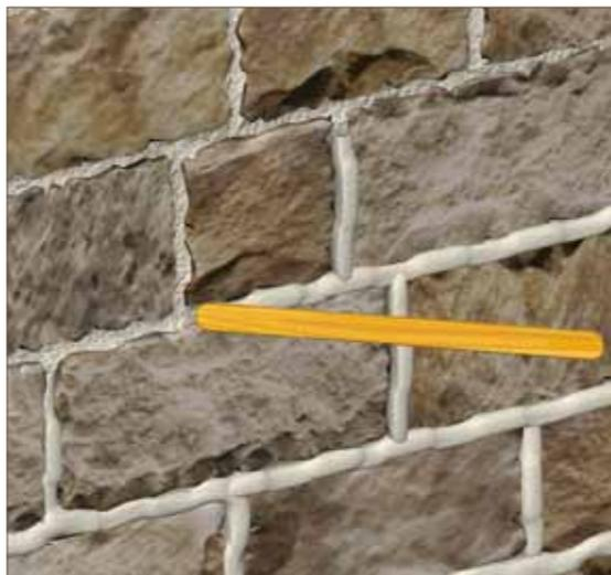
Finché la malta è morbida non va assolutamente lavorata. Solo quando essa ha raggiunto una consistenza abbastanza dura (ossia quando, toccandola con un polpastrello, non lascia più tracce di sporco sulla pelle), con un bastoncino di legno la si comprime nella fuga e la si distribuisce e modella a piacimento. In tale modo la malta in eccesso si stacca e cade a terra sotto forma di briciole consistenti senza sporcare le pietre.
