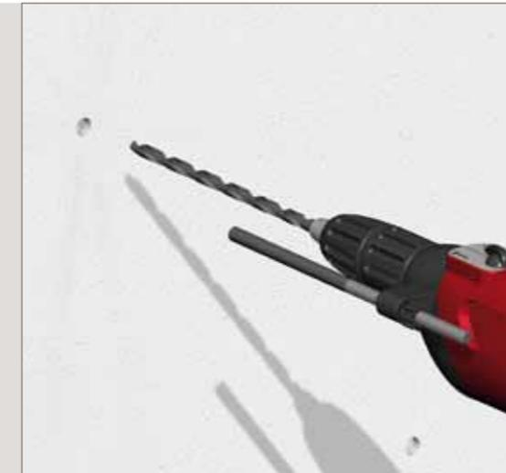
fresatura diametro 16-18 mm
