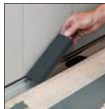
uz 2. Umetnite odstoynike u tijelo kanalice
