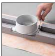
uz 3. Ponovno zavijčajte adapter
