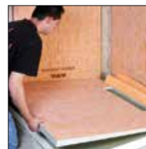
uz 3. Gurnite nagibnu ploču pod rub tijeka kanalice
