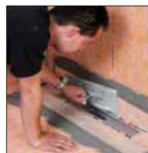
uz 4. Manžeta KERDI zalijeplite s pomoću KERDI-COLL-L
