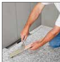
uz 5. Nosaa obloge potrebno je prekriti tankoslojnim mortom
