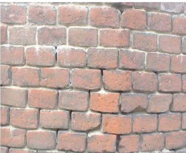
Oдноšenje ispiranjem mortova za polaganje obloga
