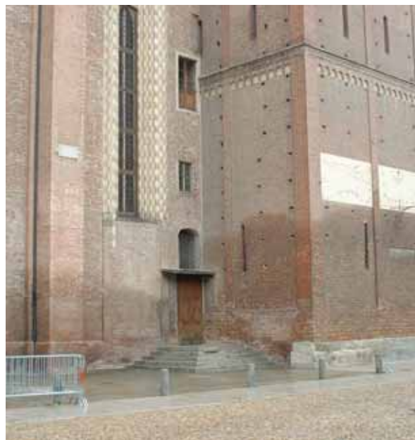
Primjer kapilarnog uspona
