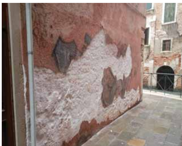
Iscvjetavanje i unutrašnja iscvjetavanja soli
